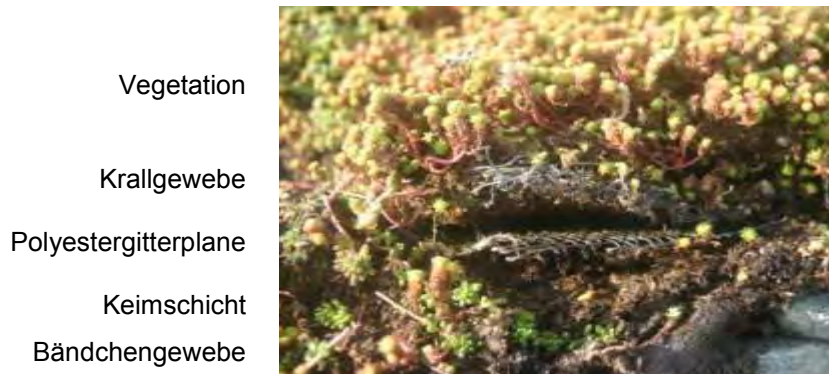
Abb. 2: Schichtenaufbau der Begrünung mit der Optigrün Vegetationsmattet SM/KG
