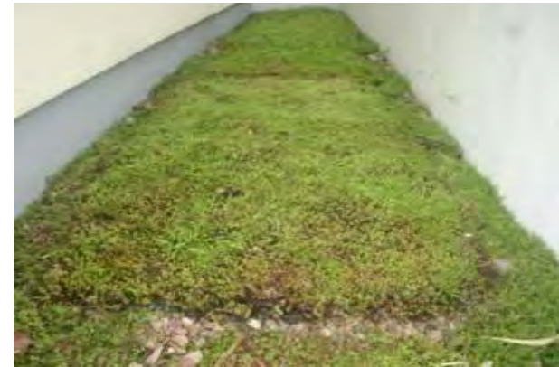
Zustand nach dem Wiederverlegen
